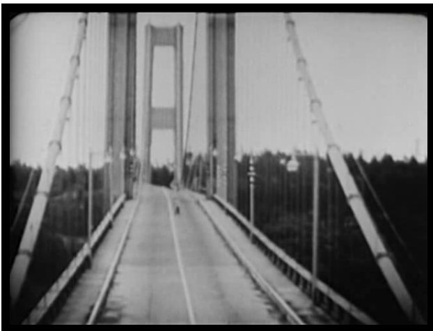
La risonanza meccanica portò alla distruzione del Ponte di Tacoma.
